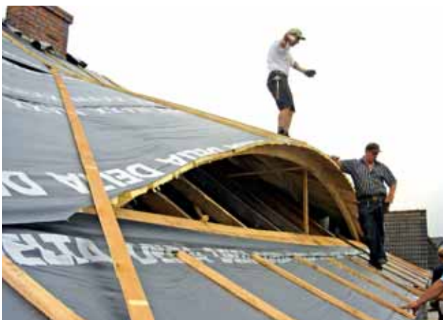
Wole oko odeskowane i przykryte membraną
