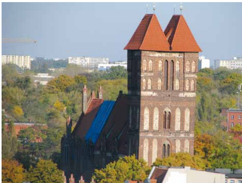
▲ Kościół św. Jakuba w Toruniu – dachy pokryte mnichem-mniszka
