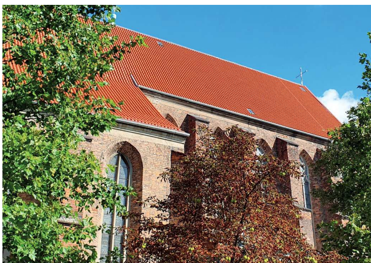
Dach kościoła pw. Bożego Ciała w Poznaniu pokryty dachówką Klasztorną E28
