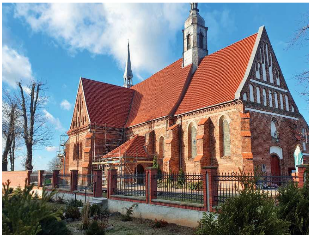
Dach kościoła pw. Bożego Ciała w Poznaniu pokryty dachówką Klasztorną E28
