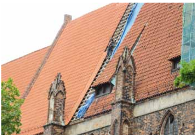
◀ Wysokie na kilkanaście metrów potacie nie były skomplikowane do krycia
