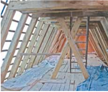
▲ Fragment więźby z 1317 roku (wiek drewna datowano metodą dendrochronologiczną)
