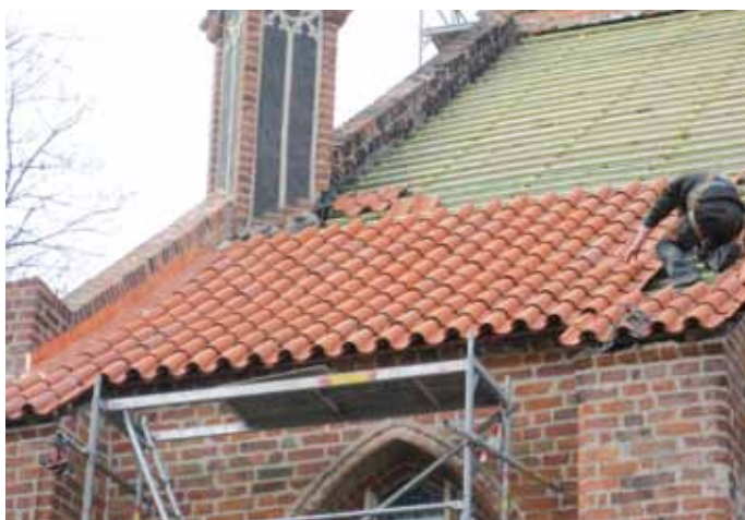
◀ Stare pokrycie leżało na zaprawie, nowe jest mocowane drutem
